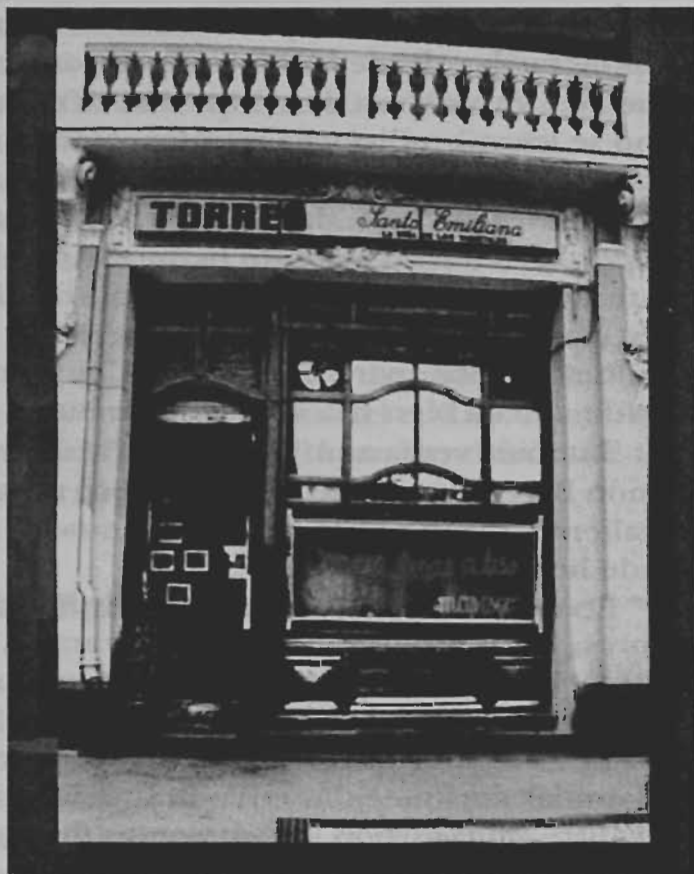
Frontis de la Confitería Torres en la Alameda de Santiago.
